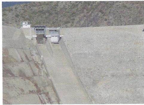
Η συνολική κατασκευή που βρίσκεται στο Δεξιό Αντέρεισμα ανήλθε σε **52.000 m<sup>3</sup>** σκυροδέματος και εξασφαλίζει μέγιστη εκροή **3.300 m<sup>3/sec</sup>**. Η μεγάλη κλίση και το μήκος της Κεκλιμένης Διώρυγας (47%) επέβαλαν την κατασκευή τριών Αεριστών εκατέρωθεν αυτής.
