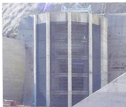
Βρίσκεται στο Αριστερό Αντέρεισμα είναι κατακορύφου τύπου με Φρέαρ Θυροφραγμάτων ύψους **55 m**, διαμέτρου **5,30 m** με διαστάσεις ανοίγματος στην θέση των Δοκών Εμφραξης **7,39 x 4,20 m** και στάθμη δαπέδου στο υψόμετρο 716,00.
