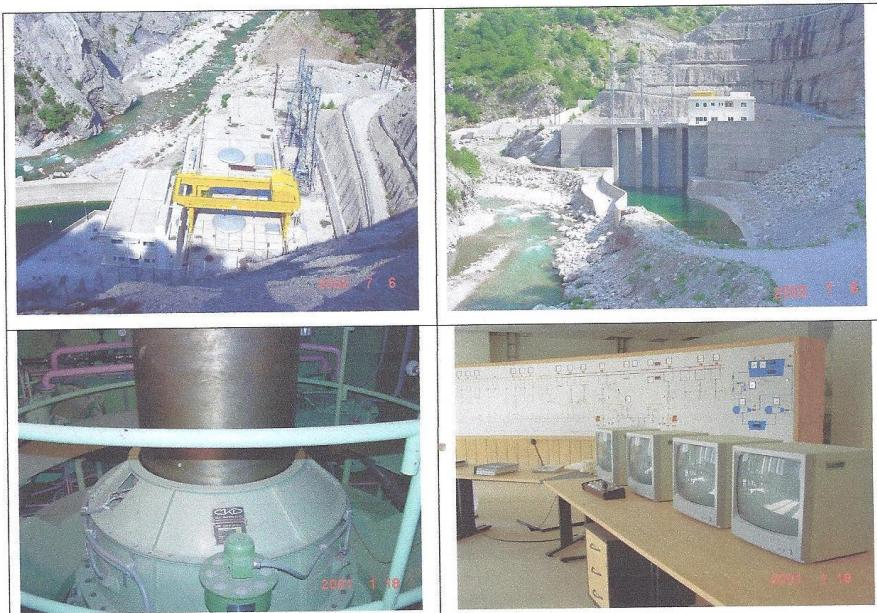
Ο Ηλετρομηχανολογικός Εξοπλισμός περιλαμβάνει Προμήθεια και Εγκατάσταση Στροβίλων D=2800MM, Ριθμιστών Στροφών, Σφαιρικών Βαλβίδων D=2300MM, Γεννητριών, Μετασχηματιστών, Θυροφραγμάτων Λειτουργίας – Εκχειλιστή – Υδροληψίας και Δοκών Εμφραξής.
